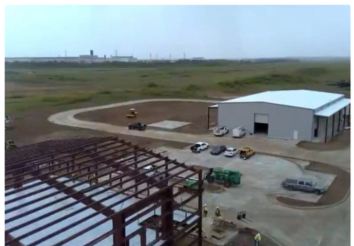
Cedar Port, Baytown: Archivbild aus der Bauphase 1 mit Stahlskelett des Innovation Centers und RPD-Halle. Quelle: abundiaimpact.com
