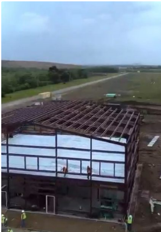
Archivbild Baufortschritt Phase 1: Innovation Center im Rohbau. Quelle: abundiaimpact.com
