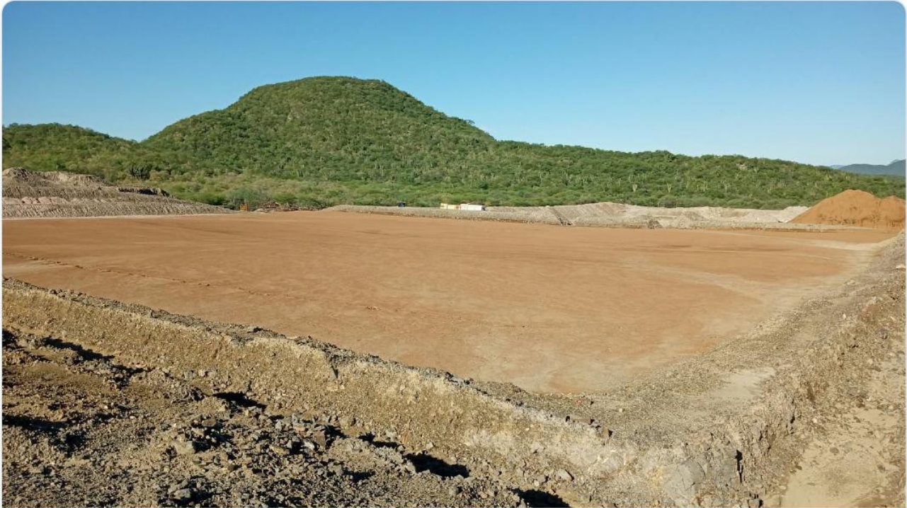
Foto: Die genehmigte 50.000-Tonnen-Haufenlaugungs-Pilotanlage bei Gran Pilar (Sonora, Mexiko) – das vorbereitete Haufenlaugungs-Pad, im Hintergrund die Sierra. Quelle: Tocvan Ventures Corp.
